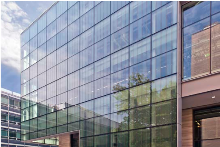
Viracon VNE24-63 Built example: MIT Nano (Boston)
