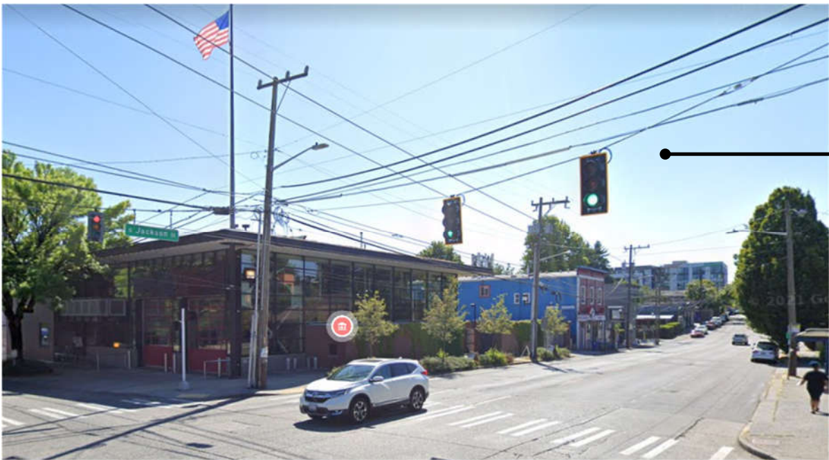
SW CORNER OF MLK JR. WAY S. & S. JACKSON ST—FIRE STATION
