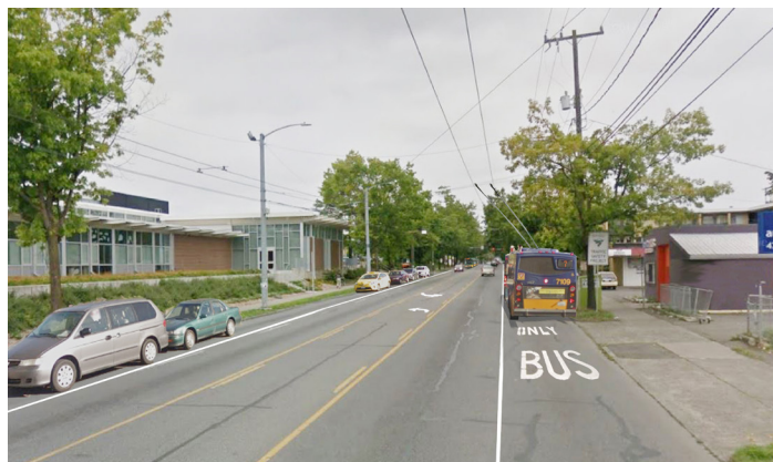
После дорожных работ (осень 2018-го)
