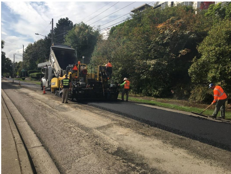
Maintenance & Operations crews pour asphalt
