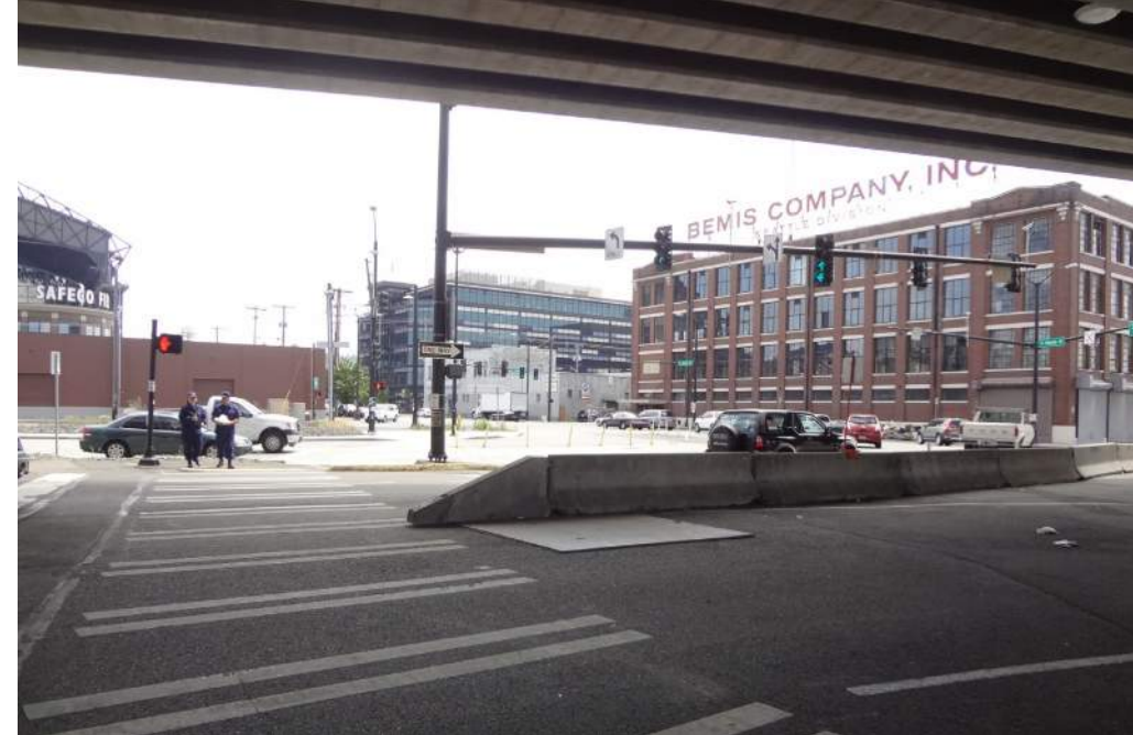
Beneath Alaskan Way Viaduct
