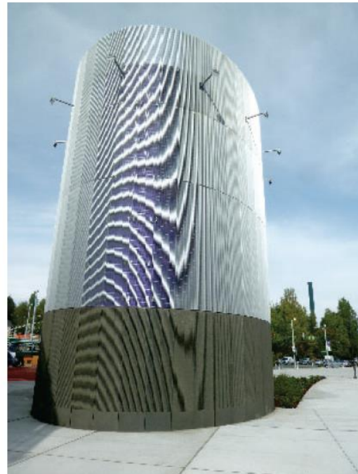
位於西雅圖UW車站的垂直通風口 Vertical ventilation at UW Station in Seattle
