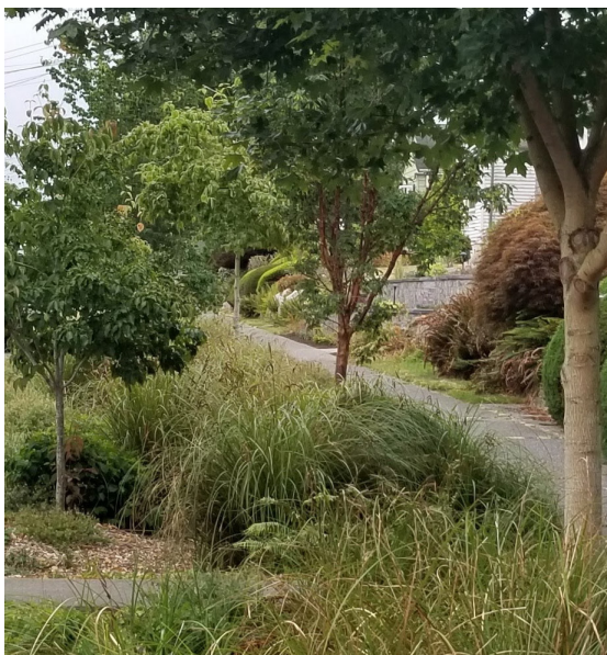
Un sistema de drenaje natural terminado en una calle residencial.
