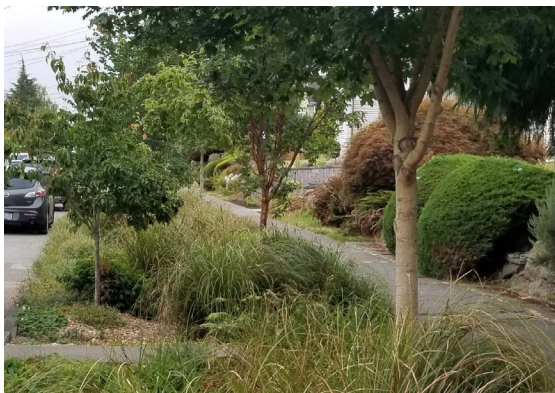
Một ví dụ của hệ thống thoát nước tự nhiên đã được hoàn tất trên đường khu dân cư.
