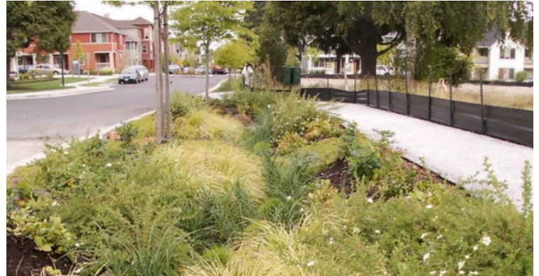
Ilustración 2. Un sistema de drenaje natural terminado
