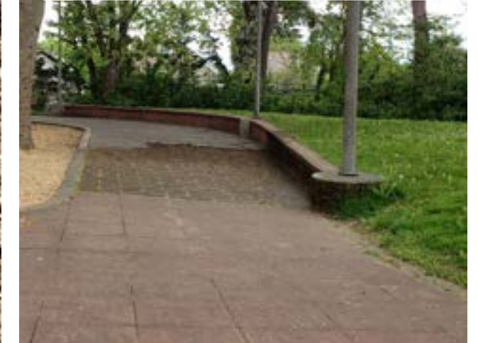
Entrada y Camino Primario al Área de Recreo
