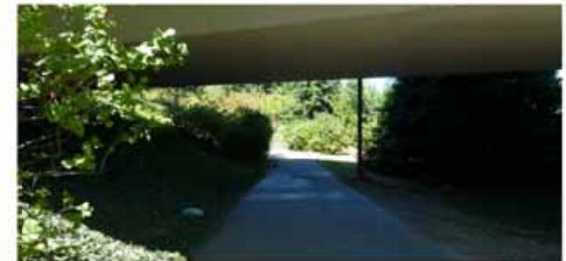
(D) MT. BAKER SUPPORT STRUCTURE - VIEW LOOKING NORTH
