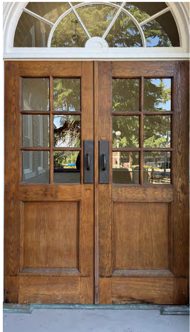
Fig. 44: Detail of door pair S-ST01-04
