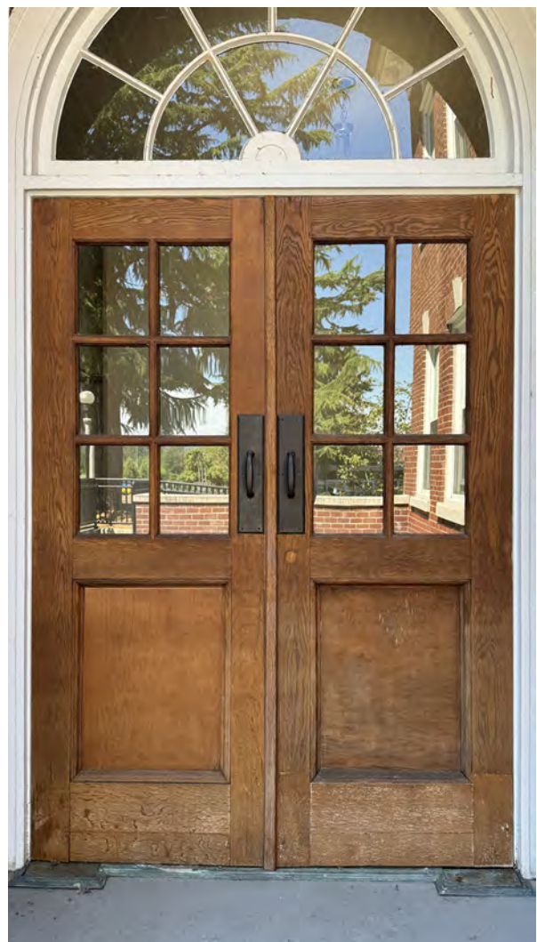
Fig. 56: Detail of door pair S-ST01-06
