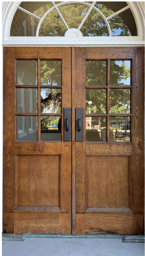
Fig. 44: Detail of door pair S-ST01-04
