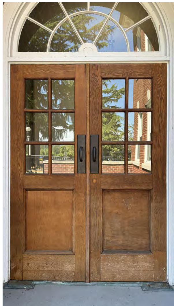
Fig. 56: Detail of door pair S-ST01-06
