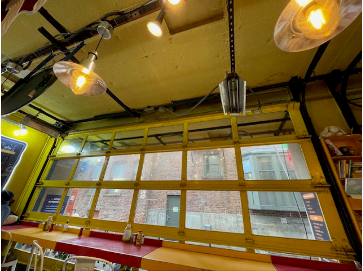
Existing roll up door track
