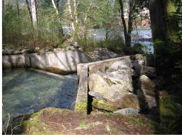
**Figure A-6. Tailrace Fish Barrier**
