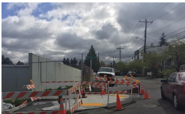
當正在建造路緣坡道時，人行道將受到限制或禁止通行
