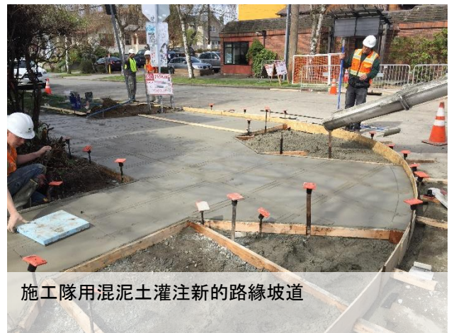
施工隊將拆除現有的路緣，然後建造新的路緣坡道
