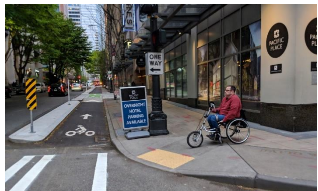
啟用新的路緣坡道
