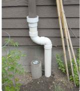
**ELBOW FITTINGS AND** CAPPED DOWNSPOUT AT **EXISTING DOWNSPOUT**
