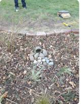
WASHED GRAVEL OR STREAM BED COBBLES AT PIPE OUTLET
