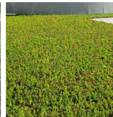
Sedum spp. Green Roof Sedum Mix
