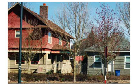
2801 S. HANFORD ST.
