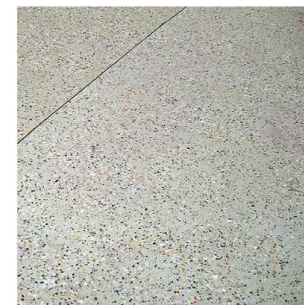
SITE - SANDBLAST CONCRETE
