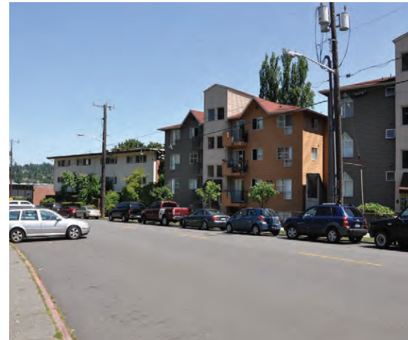
07. CONTEXT, LOOKING N. | 22ND AVE. NE.
