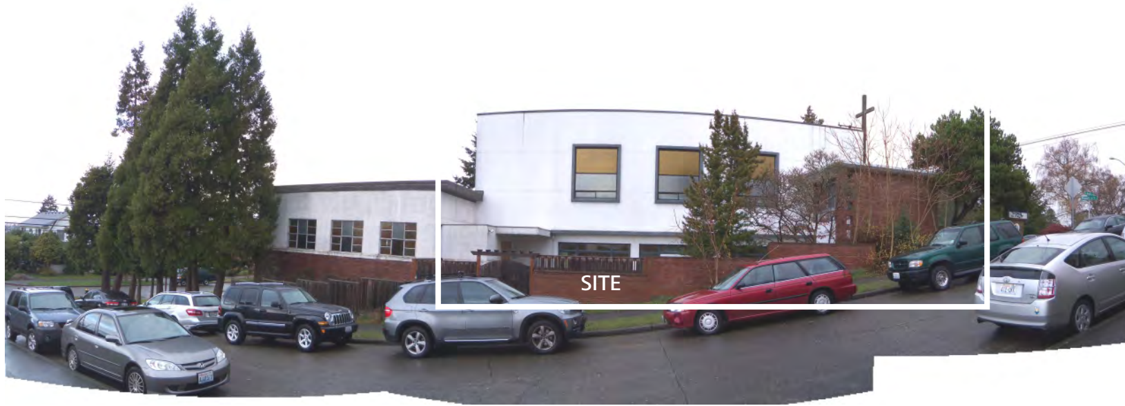
1. N. ARGYLE PL. ELEVATION LOOKING NORTH
