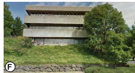
3301 Burke Ave. N. Office
