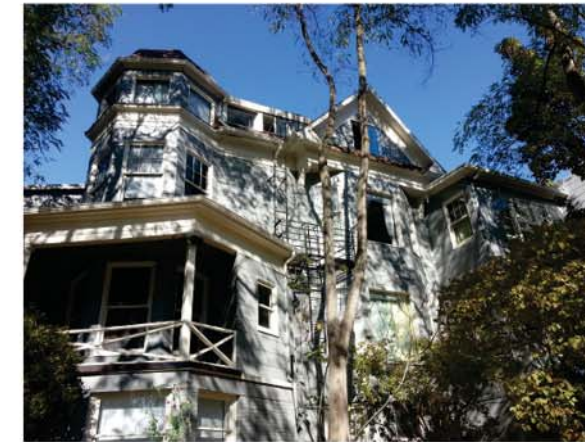
6. E. JOHN ST. LOOKING NE
