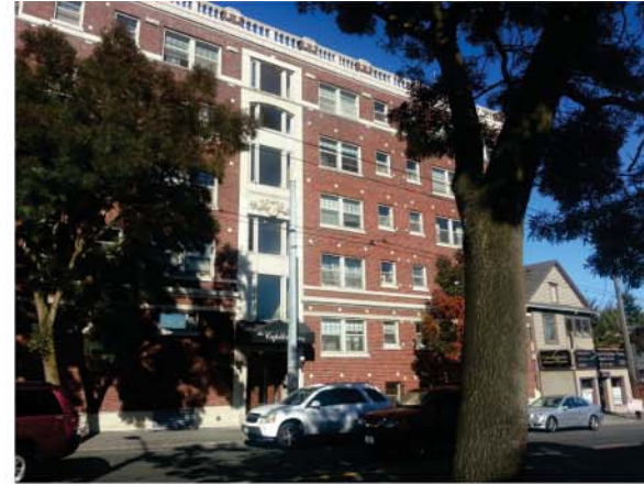
9. E. JOHN ST. LOOKING NE
