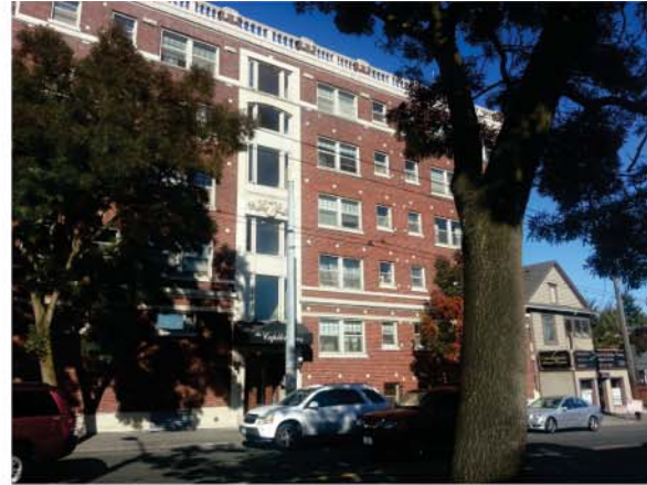
9. E. JOHN ST. LOOKING NE
