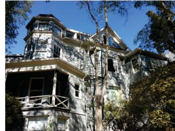
6. E. JOHN ST. LOOKING NE
