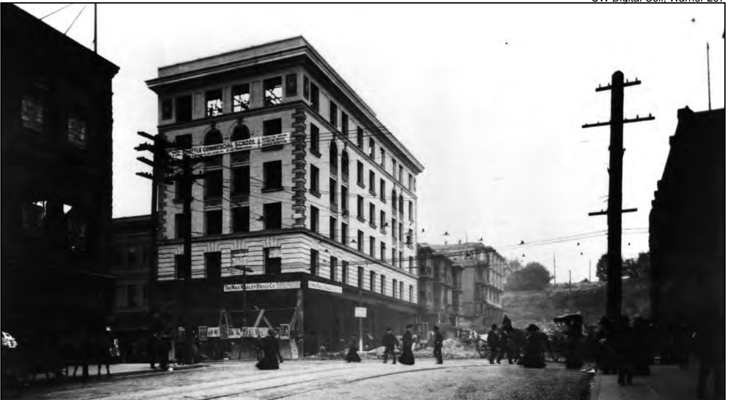
Figure 29. Eitel Building (1904, W. D. Van Siclén)
