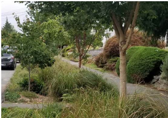
Ejemplo de un sistema de drenaje natural completo en una calle residencial.
