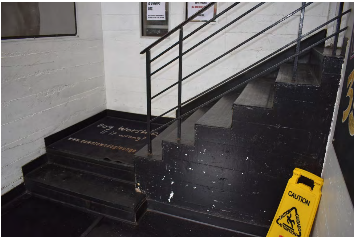
Fig. 27 – Interior, entry vestibule.
